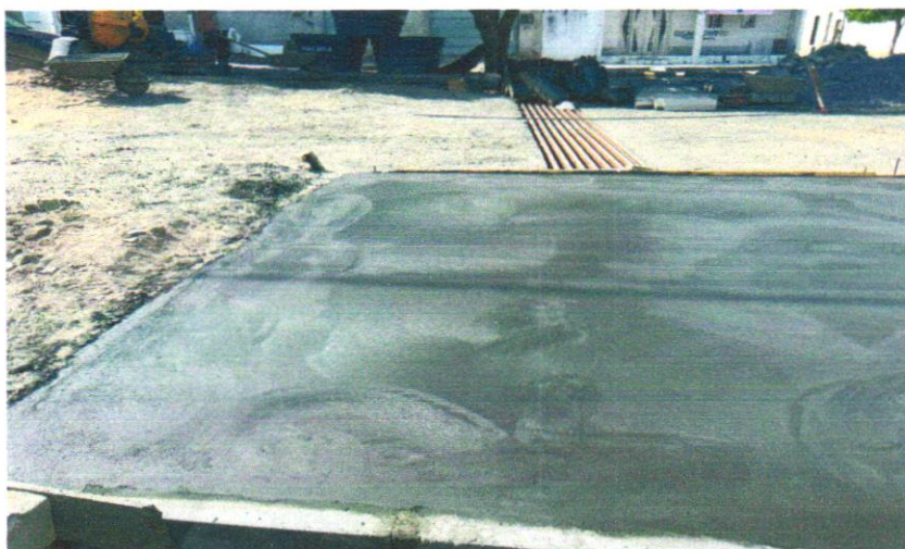
Foto 02 – PAVIMENTAÇÃO EM CONCRETO, COM ESPESSURA DE 7 CM, COM ACABAMENTO FEITO UTILIZANDO ALISADORA DE CONCRETO (HELICÓPTERO), INCLUÍDO TELA DE AÇO SOLDADA NERVURADA CA60, Q196 (3,11 KG/M²), DIÂMETRO DO FIO 5.0 MM, LARGURA = 2,45 M, ESPAÇAMENTO DA MALHA = 10 X 10 CM, JUNTA DE DILATAÇÃO EM PVC A CADA 2,00 M, CONCRETO FCK = 20 MPa
